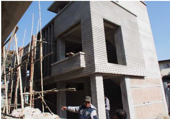
建設中の寄宿舍
