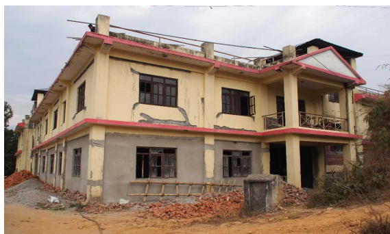
補修工事が行われた校舎
