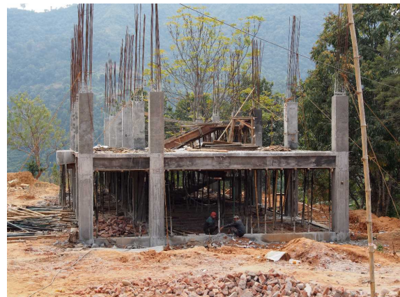
A・J・ジャンタ校校舎の再建工事
