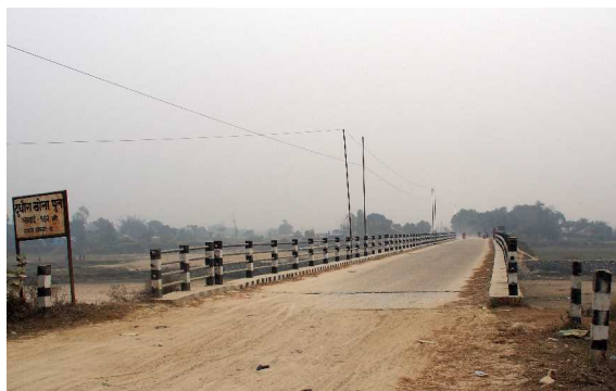
新しくできた橋
