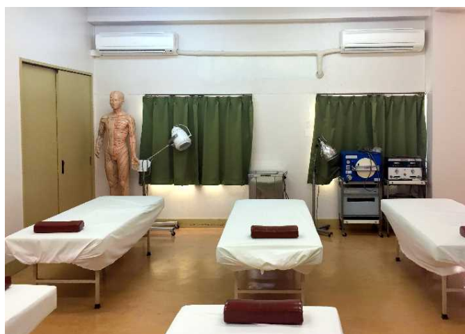
新設した室内機
